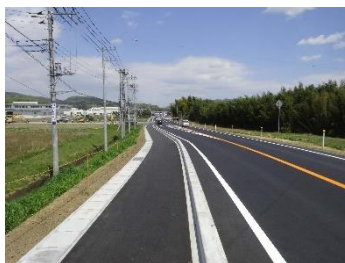
(改良整備された県道)
